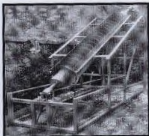
Gambar 2. Turbin ulir archimedes yang diuji.
